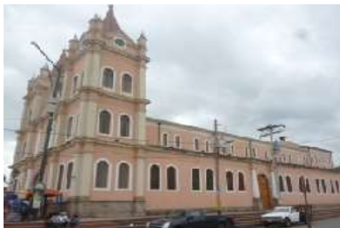
Fotografía 09. Iglesia Católica del cantón Chambo, vista externa.
